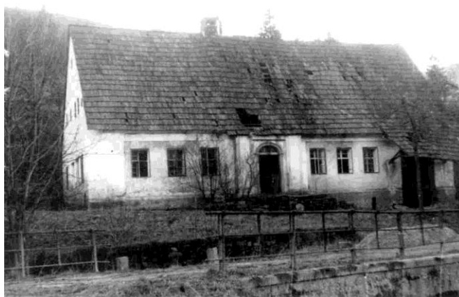
Obr.: Pohled na dům Bernarda Kutzera těsně před demolicí kolem roku 1960
